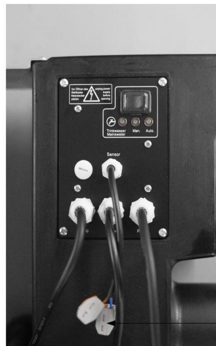
Anschluss des Schwimmerschalters
